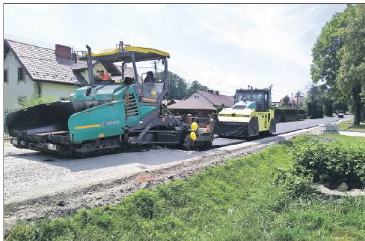
Na drogę powiatową nr 1309R wyjechał już ciężki sprzęt.
