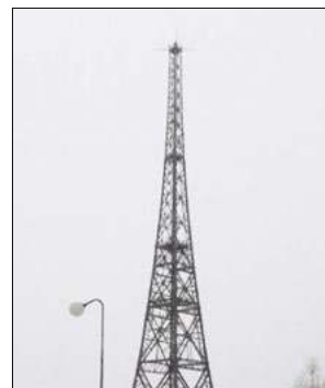
Mieszkańcy twierdzą, że droga została rozjeżdżona przez ciężki sprzęt, gdyż na jej końcu powstaje wieża na potrzeby straży granicznej
