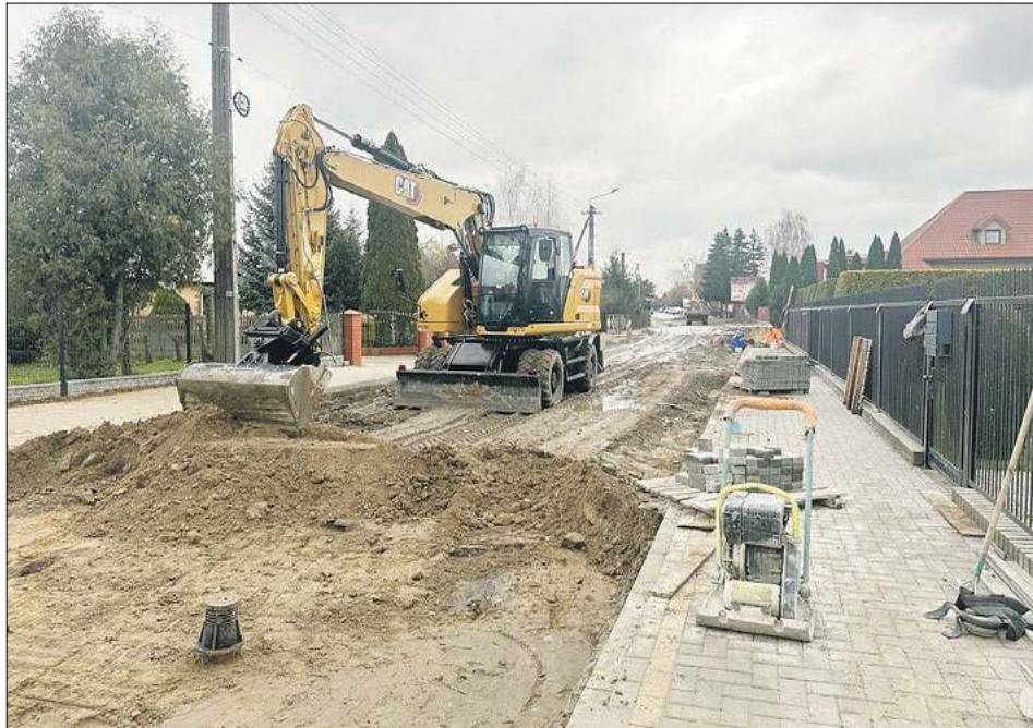
Pierwszy etap przebudowy ul. Partyzantów ma się zakończyć w kwietniu przyszłego roku. Później miasto planuje rozpoczęcie kolejnego etapu
