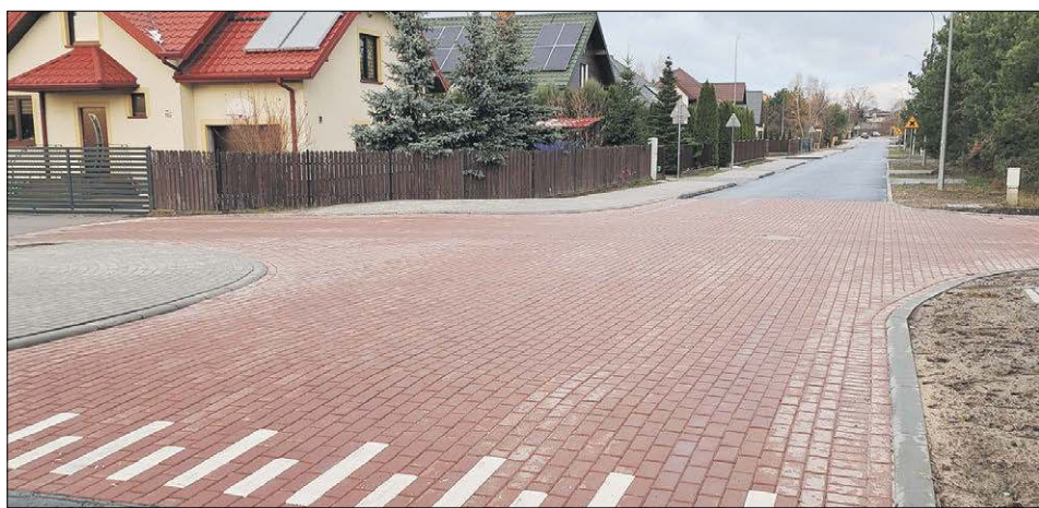
Ulica Jastrzębia po modernizacji to 400-metrowy odcinek z chodnikami, odwodnieniem i wyniesionymi skrzyżowaniami
