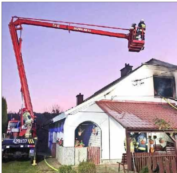
Dom wymaga generalnego remontu. W jego odbudowie chce pomóc Rada Sołecka w Gorzejowej. Fot. OSP Nawsie Brzostkie.
