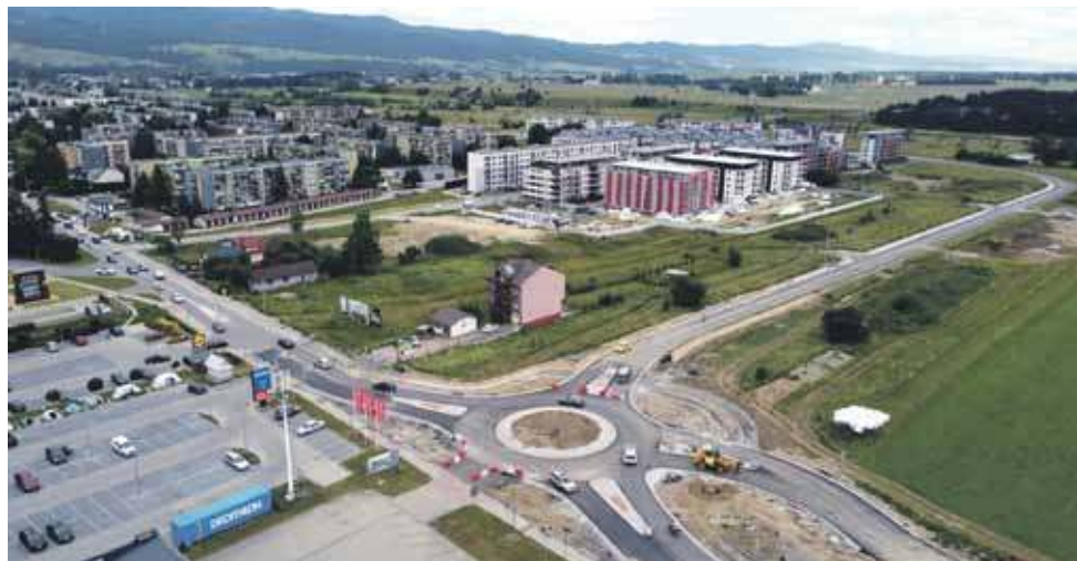
Koniec korków na Szaflarskiej - rondo gotowe.
