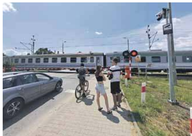
Przejazd kolejowy na ul. Ludźmierskiej ma już kategorię B.
