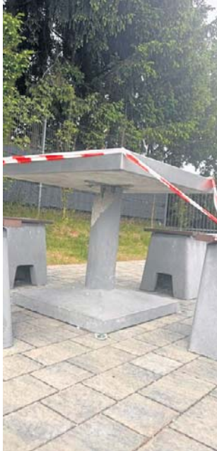
Uszkodzony został m.in. stół do gry w szachy. Sprawa została zgłoszona do Komendy Powiatowej Policji w Nowym Tomyślu
