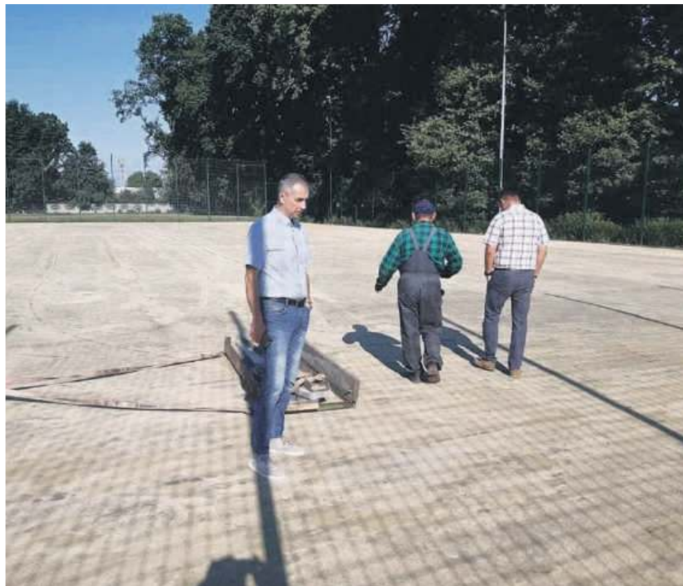
Burmistrz Gminy Żmigród Robert Lewandowski osobiście pilnuje przebiegu prac inwestycyjnych. Wielokrotnie pilotował remontu nawierzchni miejscowego Orlika
