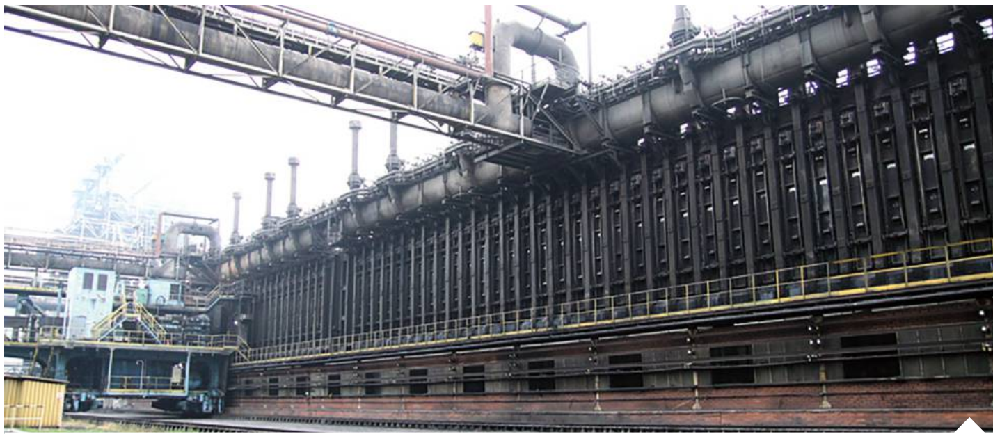
ArcelorMittal wyłącza baterię koksowniczą | fot. mat. pras./d
