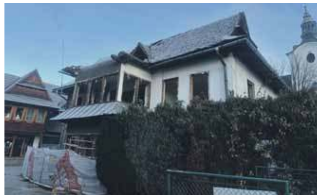
Ruszyła rozbiórka starej poczty i OPS...
