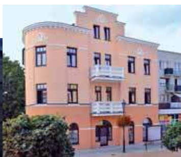
Kamienica przy ul. Warszawskiej 18 po renowacji
