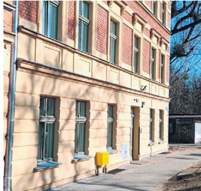
Tak po kompleksowym remoncie wygląda teraz zabytkowa kamieniczka przy ul. Poznańskiej 66
