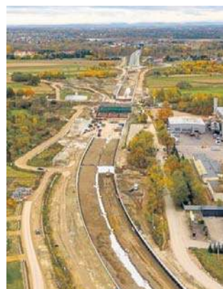
Budowa przejazdu pod czynną linią kolejową
