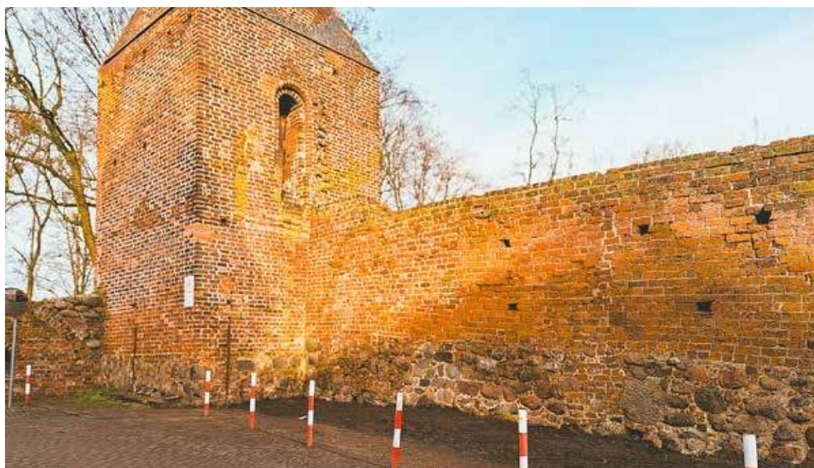
Poddawany modernizacji fragment murów obronnych przy ul. Kasztelańskiej
