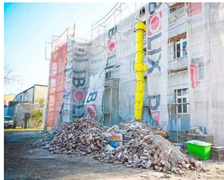
Kolejne kamienice w remoncie - tym razem przy Młyńskiej i Konopnickiej
