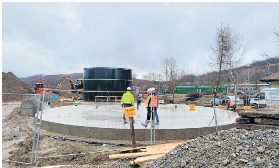
Budowa oczyszczalni ścieków w Lutczy. Wartość inwestycji to 10,6 mln zł
