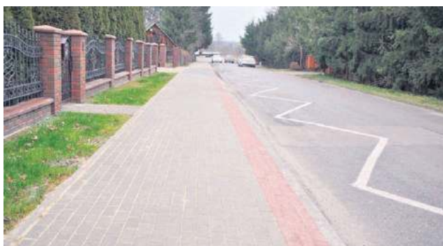
Prace na ulicy Targowej w Skokówce pochłonęły ponad 500 tys. zł.
