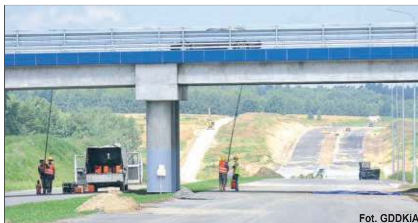
Budowa całej trasy w stronę granicy z Ukrainą jest podzielona na dziewięć etapów.
