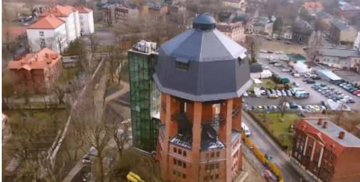
► Do wieży dobudowana została przeszklona klatka schodowa Fot. UM Zabrze
