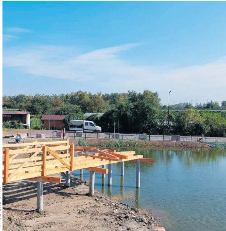
Nad oczkiem powstaje przejście tarasowe
