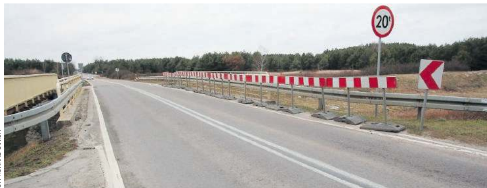
Na Jodłowce na powstanie nowa przeprawa mostowa
