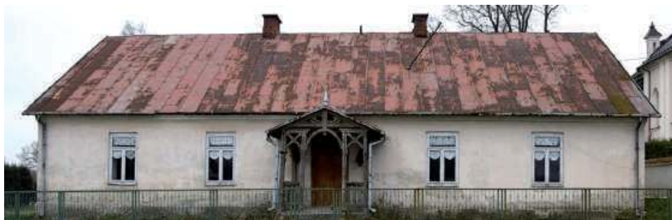
Obecnie stara plebania stoi pusta. Władze gminy Baranów zamierzają przebudować budynek na cele kulturalne i turystyczne. Po zorganizowaniu przetargu i wyborze wykonawcy prace ruszą w przyszłym roku
