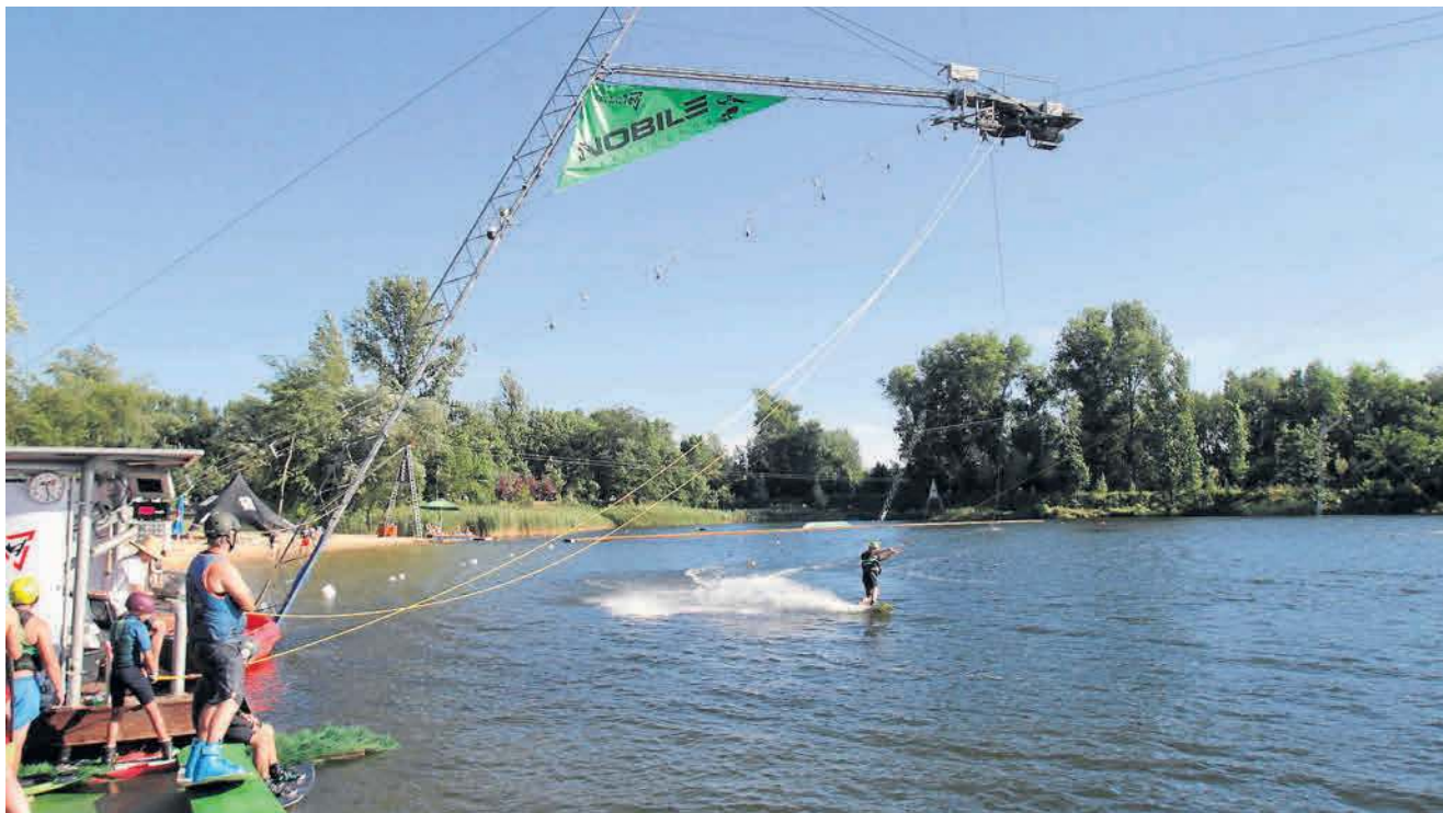
Na tor w Sosnowcu składa się pięć takich słupów. Lina zawieszona jest na wysokości 10,5 m, a z brzegu zawsze ktoś obserwuje pływającego
