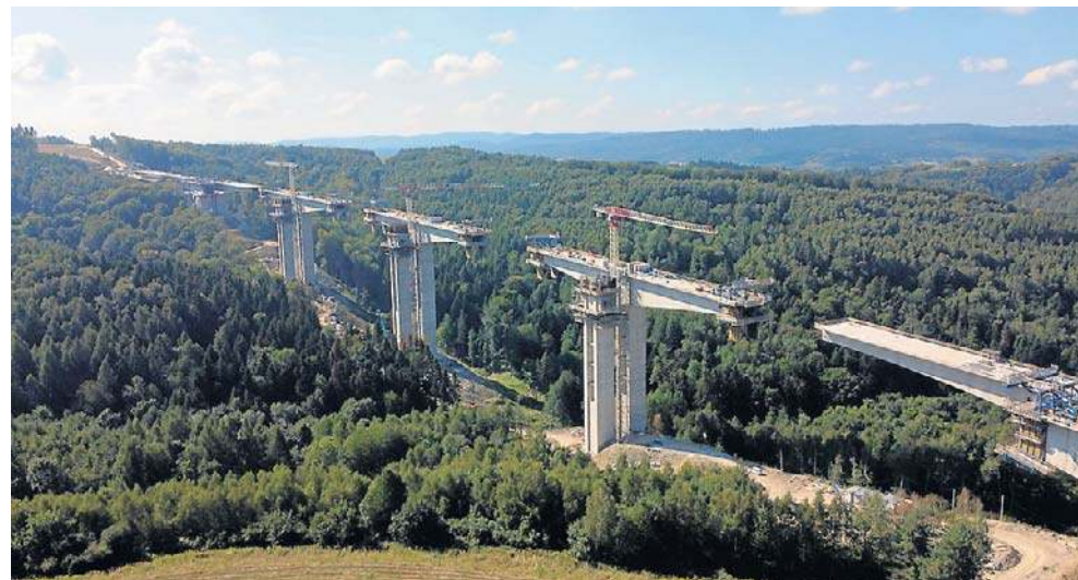
Ustrój nośny estakady wznosi się nad dnem doliny na wysokość blisko 120 m, a filary sięgają 80 m, co stanowi najwyższy wynik w Polsce
