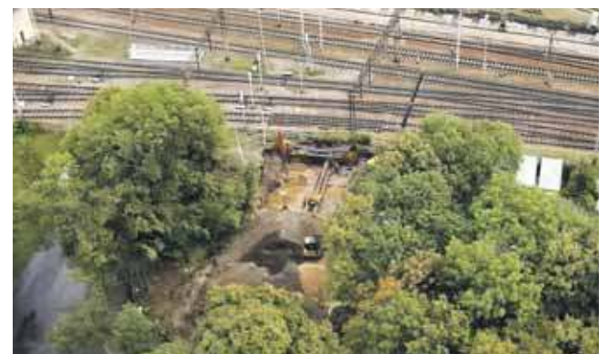
Budowa tunelu będzie o 2 mln 860 tys. zł droższa
