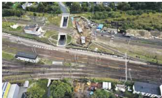
Zgodnie z nowymi warunkami tunel ma zostać posadowiony o 75 cm głębiej, niż wcześniej zakładano
