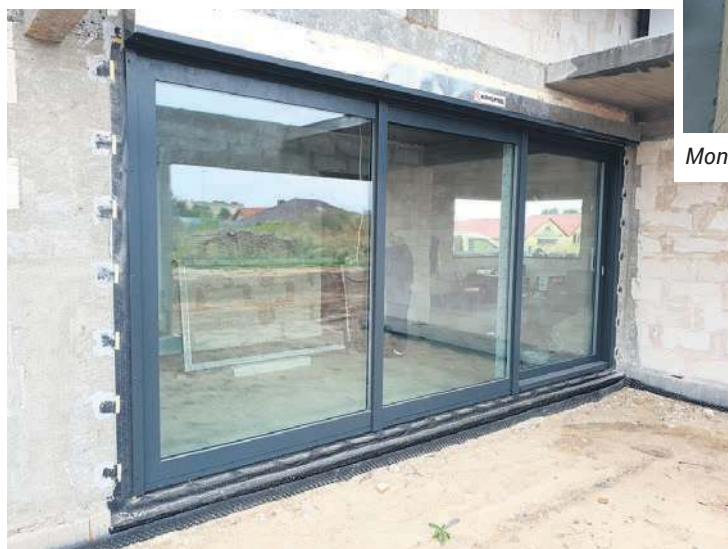
Aluminiowe drzwi przesuwne z roletą podtynkową.
