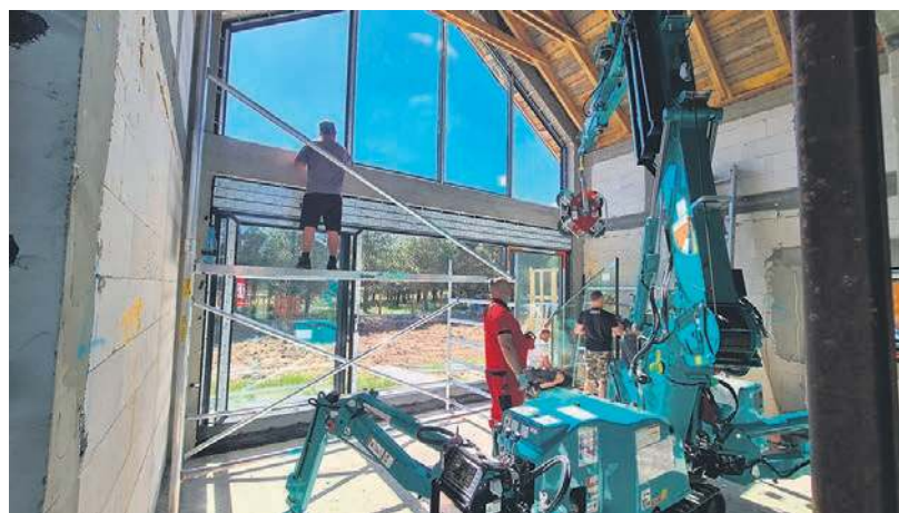
Montaż okien wielkogabarytowych z użyciem dźwigu.
