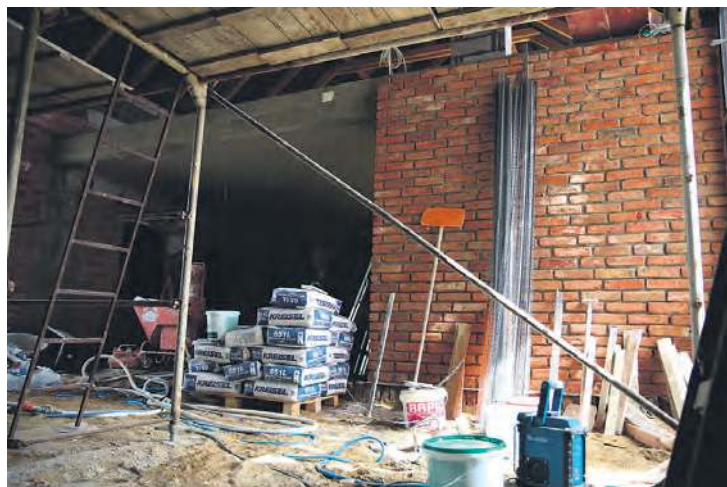
Trwają intensywne prace na zewnątrz i wewnątrz budowy.
