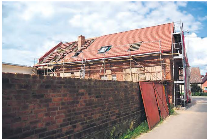
Mur od strony ul. Cmentarnej zostanie rozebrany.
