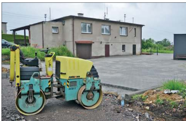
Przy OSP Turzyczka praca idzie pełną parą. Na razie zewnątrz, a wkrótce również wewnątrz remizy.
