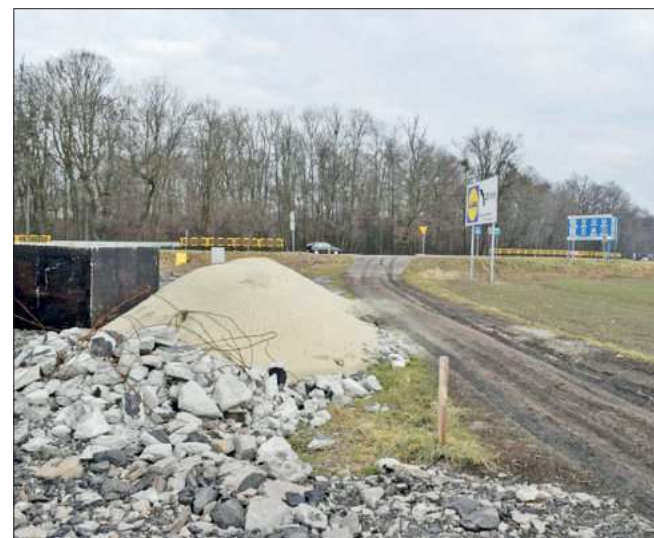
Widoczna na zdjęciu droga gruntowa znajduje się zbud blisko skrzyżowania z DK 78. Właściciel działki inwestycyjnej do której prowadzi droga musi czekać, aż gmina wytyczy nową. I czeka na to już kilka lat.
