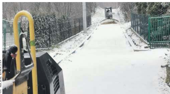
Trwa przebudowa ul. Zamkowej w Babicach
