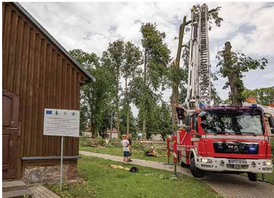
Wiatr uszkodził aż 15 drzew znajdujących się wokół kościoła w Uniecku, ale tej pięknej, zabytkowej świątyni nie ruszył. Czyżby opatrność nad nim czuwała?
