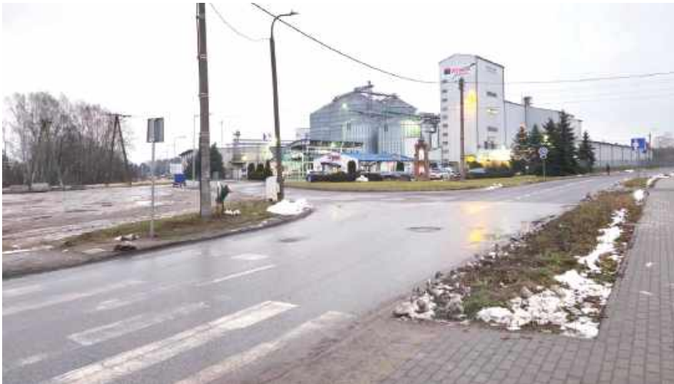
Jedną z inwestycji będzie przebudowa ul. Kościuszki w Międzyrzeczu Podlaskim
