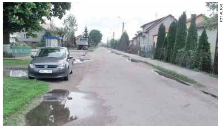
Droga przez Kowalewo przed modernizacją
