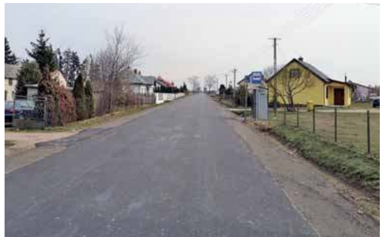
Fragment zmodernizowanej drogi
