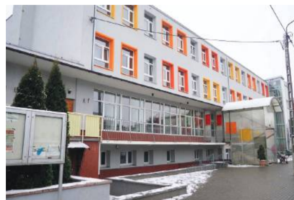
Kontrolę w Szkole Podstawowej nr 4 w Strzelinie przeprowadzono jesienią 2025 roku
