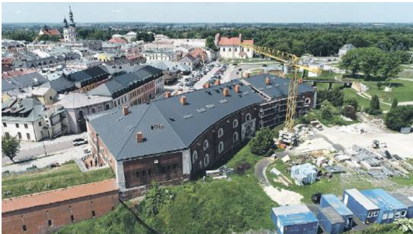
Remont Bastionu VI i Nadszańca
