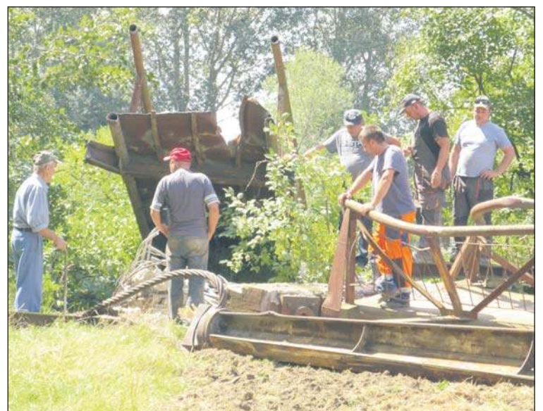
Kładka nad Wisłoką zdemontowana została w czwartek 4 sierpnia.
