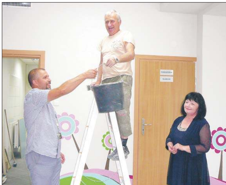
Przedszkole dla dzieci niepełnosprawnych przy ulicy Parkowej jest już prawie gotowe. Ostatnie prace związane są głównie z malowaniem. Na zdjęciu od lewej: Paweł Morawczyński, Tadeusz Błazejowski i Elżbieta Pieprzak.
