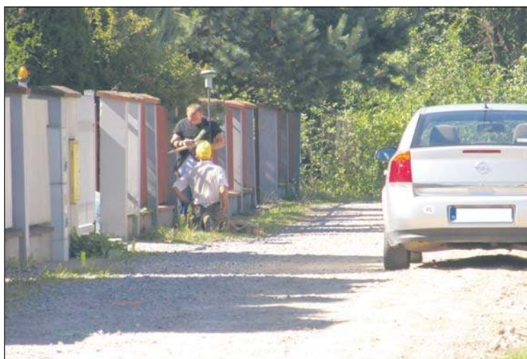
Trwają przygotowania do przebudowy ul. Ligęzów.
