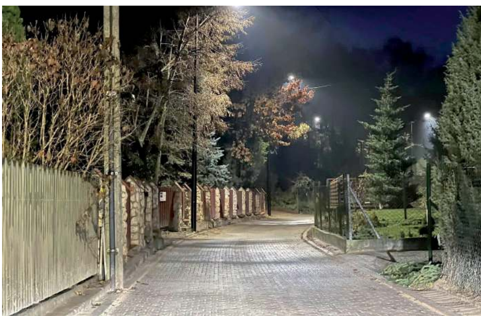
Inwestycja na ul. Bełżyckiej i Kębelskiej pochłonęła w sumie prawie 1,6 mln zł. Część środków, z których pokryto koszty prac to pozyskane przez samorządowców dotacje
