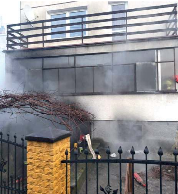
Dominik Kęsik W wyniku rozszczelnienia się butli gazowej w budynku spłonęła część garażu
