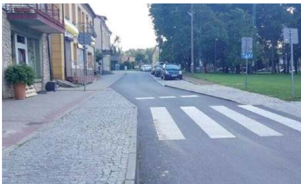
Na ul. Bełżyckiej prace oprócz przebudowy sieci wodociągowej obejmowały także wymianę nawierzchni drogi. Zmianę zwłaszcza w centrum Wąwolnicy widać gołym okiem
