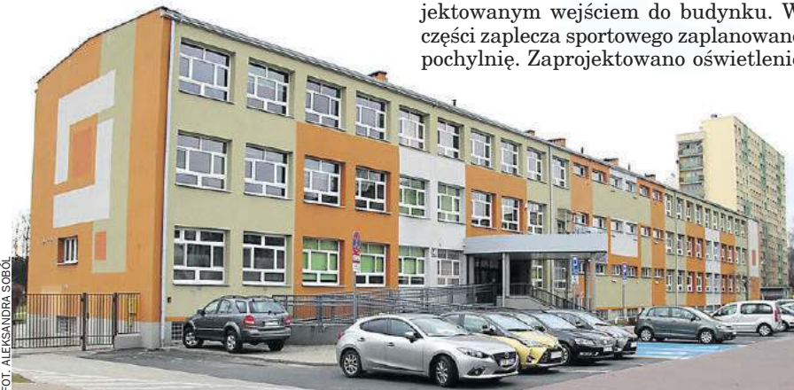
W „siódemce” na zewnątrz budynku pojawi się winda
