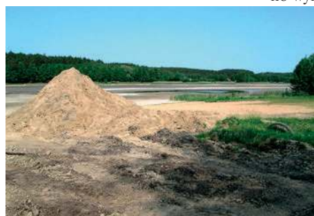
Była plaża, jest teren budowy
