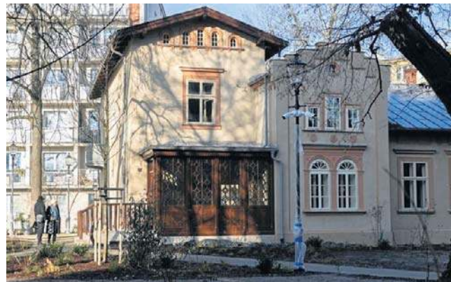
W Kossakówce trwają ostatnie prace kosmetyczne
