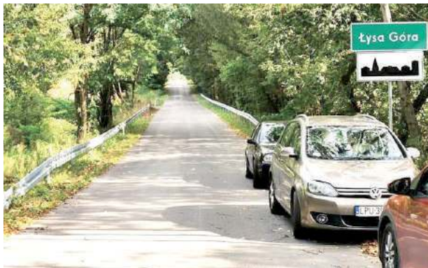
Długość wyremontowanych dróg pomiędzy w Czołną, Łysą Górą oraz Śniadówką wynosi prawie 5 km
