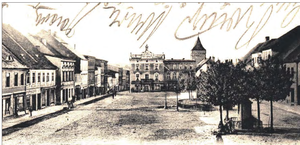
W 1. połowie XVIII w. w centralnej części Rynku w Białej znajdowała się jakaś budowla, zapewne ratusz. Być może już wtedy obok niego stały dwa inne budynki wzmiankowane na początku XIX w. – Dom Akcyzowy i wartownia z remizą.
