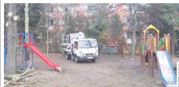
W ramach dotychczasowych działań poprawiono stan nawierzchni oraz uporządkowano teren
