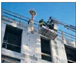
Nad nowym budynkiem starostwa wiechę — symbol szczęścia zawiesili starosta Mariusz Filipiuk i wykonawca prac Paweł Niczyporuk
