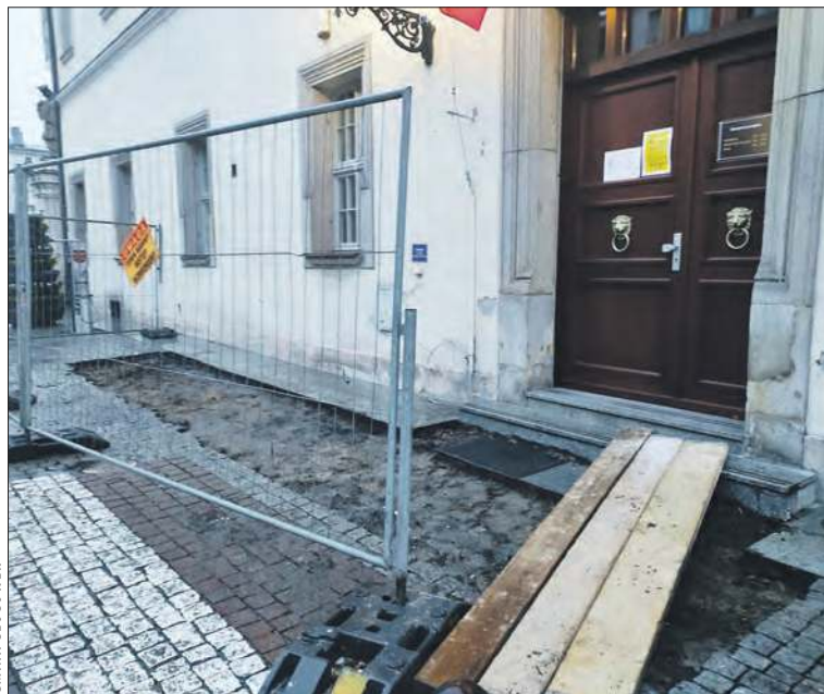
Przed wejściem do ratusza w Głogówku trwają prace przy budowie podjazdu dla niepełnosprawnych. Inwestycja o wartości ok. 40 tys. zł musiała być poprzedzona uzgodnieniami z wojewódzkim konserwatorem zabytków. (d)
