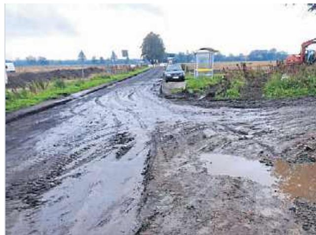
Mieszkańcy budynku przy ul. Słupskiej w Jezierzycach mają problem z dotarciem do swojej posesji
