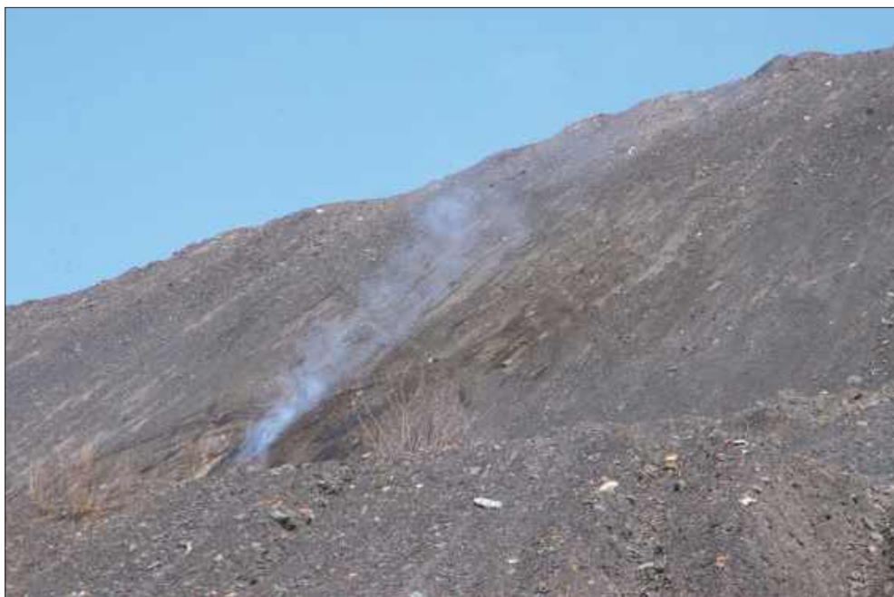
■ Na hałdzie Wrzosa I trwają prace związane z utworzeniem okrywy, jednak zjawiska zapożarowania postępują i mogą pojawiać się w nowych miejscach
