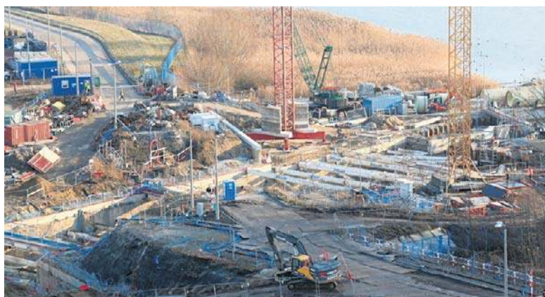
Na placu budowy pracuje codziennie ponad tysiąc osób
