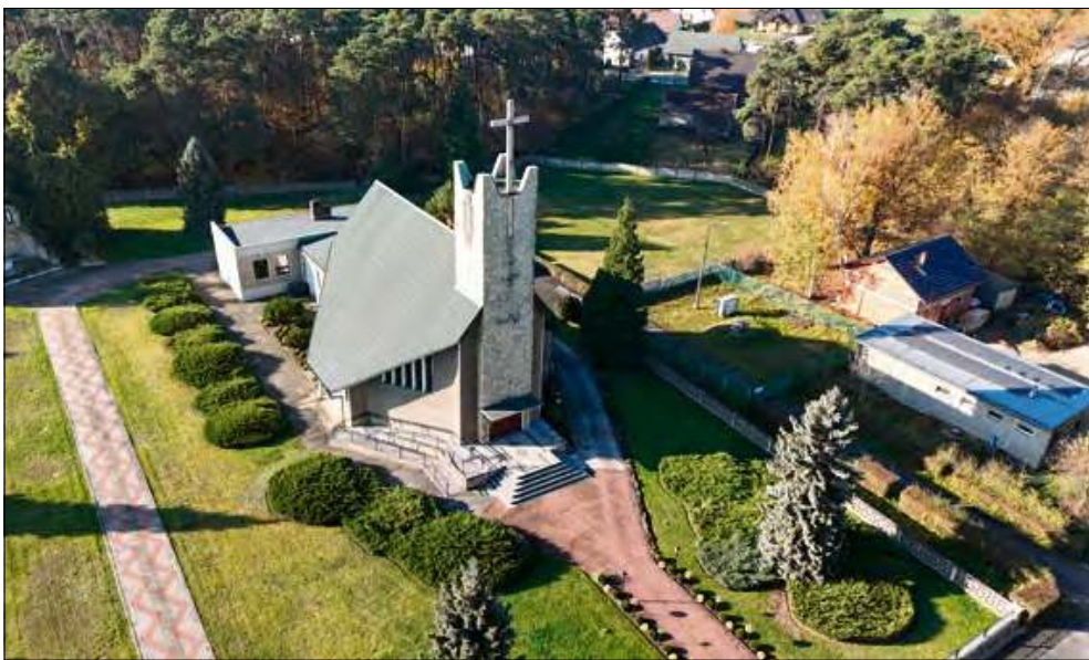
Widok z drona na kościół pw. Trójcy Świętej w Choruli.
