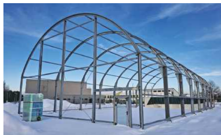
Budowa hali Olimpia z wielofunkcyjnym krytym boiskiem sportowym
