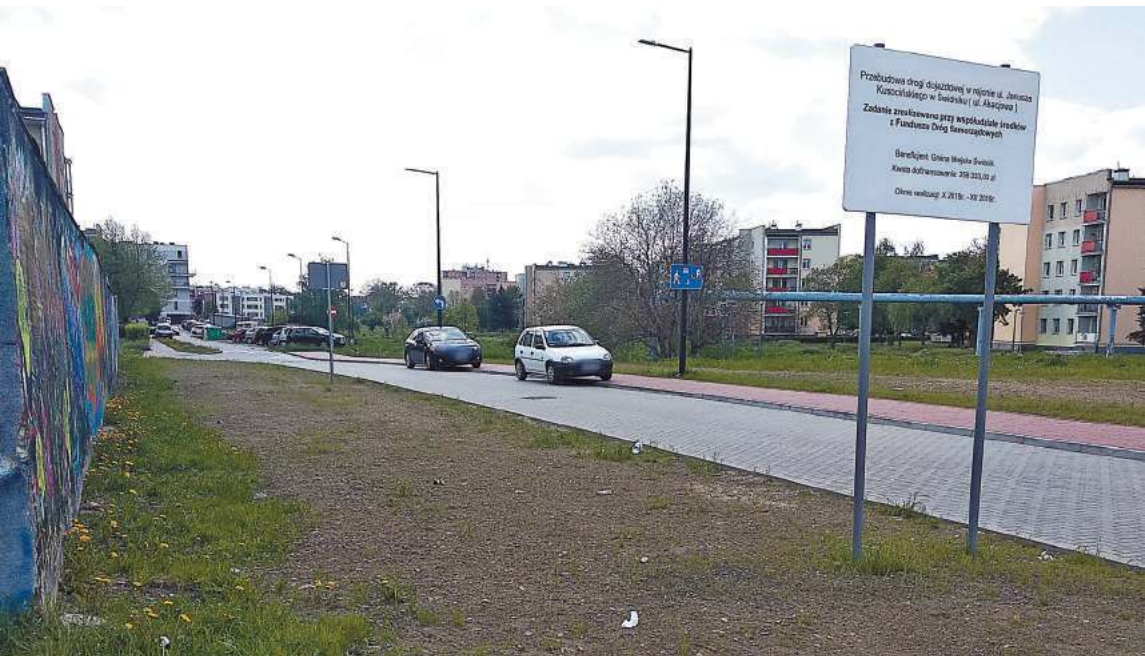
Do swojej interpelacji radny dołączył zdjęcie unaoczniające problem blokowania chodnika przy ul. Akacjowej przez parkujące auta
