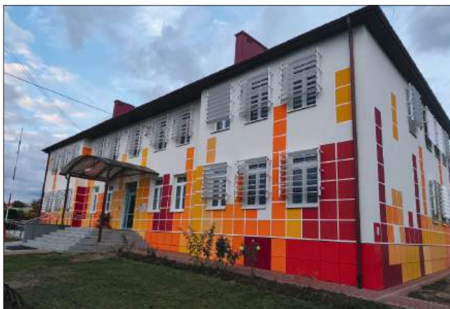
Zmodernizowany budynek szkoły podstawowej w Zdziarcu.
