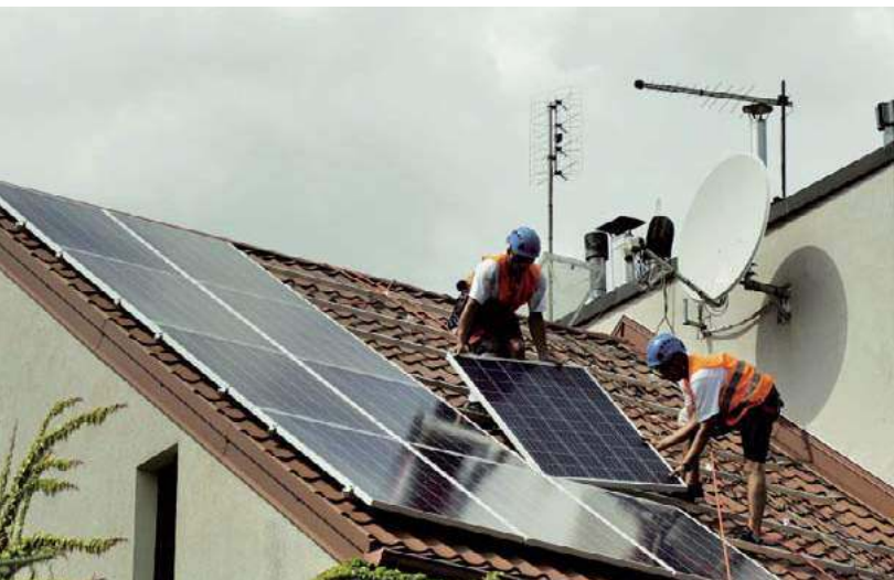
📌 Najkorzystniejszy kąt nachylenia paneli fotowoltaicznych to 35°. A. PAPLIŃSKI
