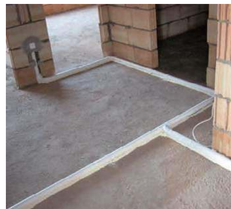
📌 Rury instalacji centralnego odkurzania mają niewielki przekrój, dlatego można je łatwo ukryć w przestrzeni podłogi albo sufitu. TOPVAC
