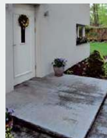
❷ Podest na ganku wykonano z płyt, wspartych na chodniku.
