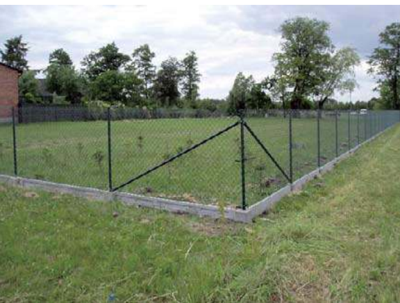
🔗 Siatka z rolki i prefabrykowana, betonowa podmurówka – takie ogrodzenie stawia się tanio i szybko. ARCHIWUM BD
