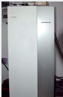
🔌 Powietrzna pompa ciepła współpracuje z wodnym ogrzewaniem podłogowym.
