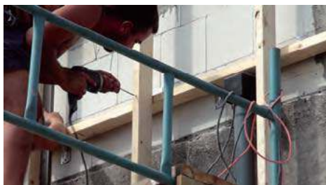
Ruszt konstrukcyjny wykonuje się z listew z drewna lub z metalu. ARCHIWUM BD
