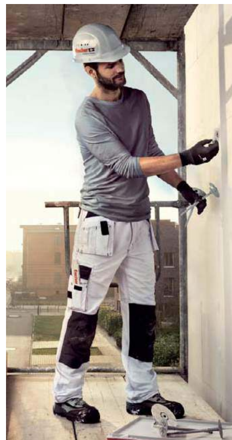
📍 W Polsce króluje technologia dwuwarstwowa – do ścian nośnych mocuje się ocieplenie i najczęściej pokrywa tynkiem cienkowarstwowym. FISCHER POLSKA
