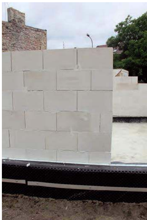
🔧 Spoiny pionowe w kolejnych warstwach muru powinny mijać się w połowie bloczka. J. WERNER
