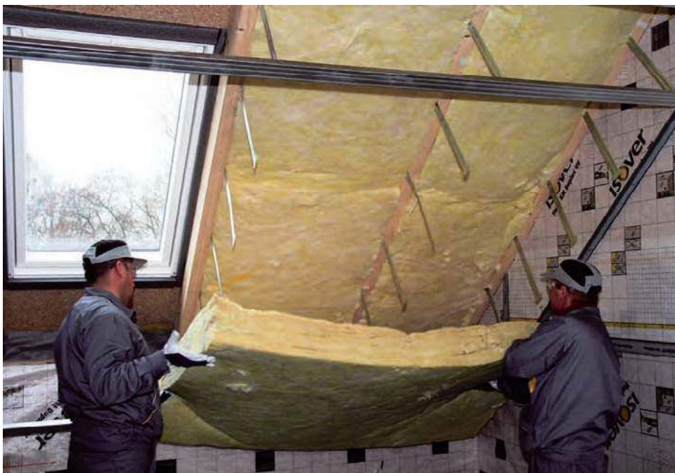
☛ Połacie dachu skośnego ociepla się najczęściej wełną, mocowaną w dwóch warstwach. ISOVER
