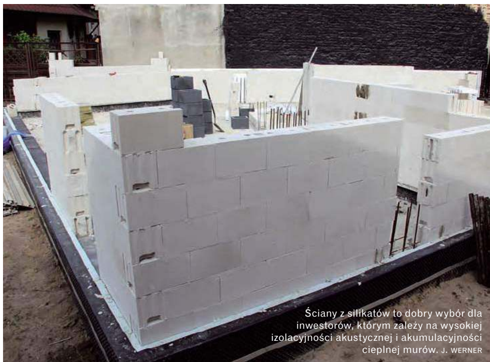
🔧 Elementy łączone na pióro i wpust nie wymagają stosowania spoiny pionowej. J. WERNER
