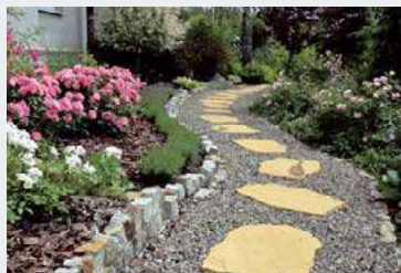
❶ Igor sam ułożył ścieżkę z płytami betonowymi, grysem i obrzeżem z kostki granitowej.
