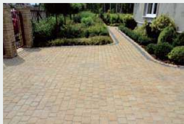
❶ Kostkę dwuwarstwową z betonu wykończono podjazd i główne ścieżki.
