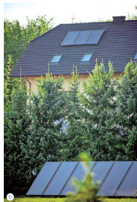
📍 Kolektory można instalować również na konstrukcjach wsporczych: na dachach płaskich (a BUDERUS), na gruncie (b HEWALEX).
