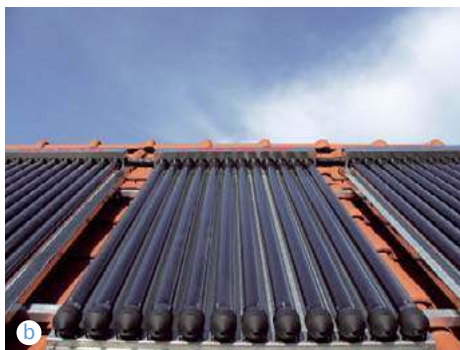
📍 Dwa najpopularniejsze typy kolektorów słonecznych – płaski (a GALMET) i próżniowy heat pipe (b NIBE-BIAWAR)
