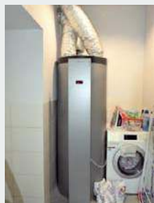
1 Kompaktowa powietrzna pompa ciepła z 300 l zasobnikiem przygotowuje tylko c.w.u.
