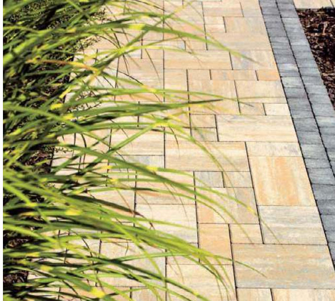
Grubość elementów na ścieżki ogrodowe wynosi minimum 4 cm, choć często stosuje się grubsze np. 6 cm. VESTONE
