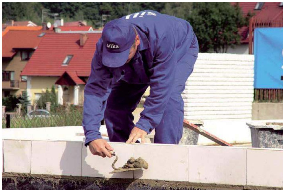
❷ Nawet przy murowaniu na cienką spoinę, pierwszą warstwę układa się na zwykłej zaprawie. Trzeba ją idealnie wypoziomować. XELLA (SILKA)
