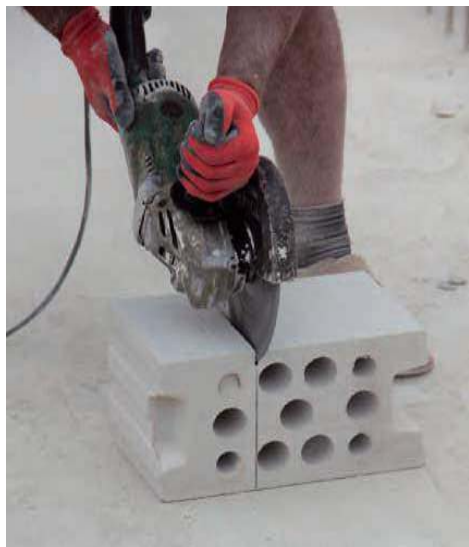
🔧 Bloczki silikatowe są twarde. Do ich cięcia stosuje się np. szlifierki kątowe. J. WERNER
