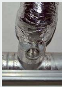
2 Fragmenty przewodów z trójnikiem do czerpania powietrza z garażu.
