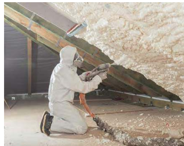
☛ Alternatywą dla wełny jest piana PUR nanoszona natryskowo. PCC PRODEX
