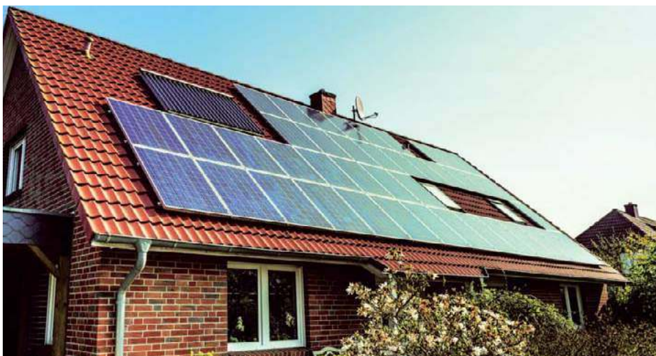
🔗 Żeby zaspokoić zapotrzebowanie na prąd, na dachu typowego domu trzeba zainstalować 20–30 m 2 paneli fotowoltaicznych. Do podgrzewania c.w.u. wystarczy kilka m 2 kolektorów. DE DIETRICH
