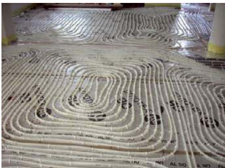
➤ Ogrzewanie podłogowe to system niskotemperaturowy. Dlatego jest szczególnie polecane do domów z pompą ciepła. ECOPOOL-SYSTEM
