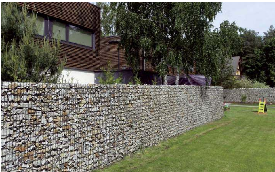
🔗 Gabiony, czyli metalowe kosze wypełnione np. kamieniami, to u nas ciągle nowość. KONSORT
