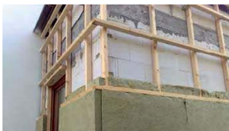
Ruszt konstrukcyjny wykonuje się z listew z drewna lub z metalu. ARCHIWUM BD
