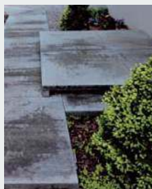
❶ Płyty ułożono na podsypce piaskowo-cementowej, bez obrzeży.
