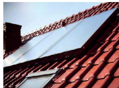
📍 Najlepsze miejsce na montaż solarów – skośny dach o kącie nachylenia 45°, zwrócony na południe. HEWALEX
