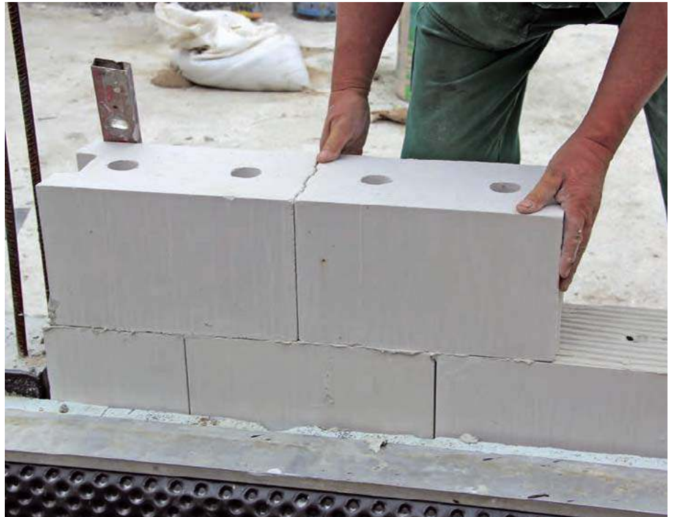
❗ Do układania kolejnych warstw muru można przystąpić dopiero po związaniu pierwszej. J. WERNER
