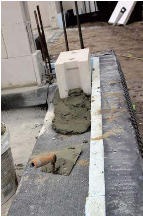
❗ Pierwszą warstwę bloczków muruje się na tradycyjnej zaprawie cementowej, układanej na izolacji poziomej np. z papy. J. WERNER
