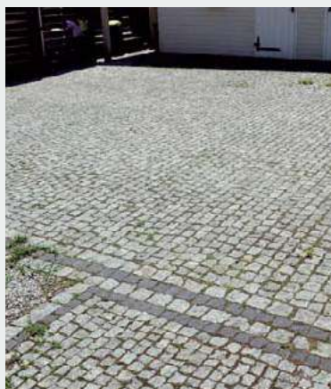
Kostkę z granitu ułożono rzędami i otoczono rantem z kostki bazaltowej.
