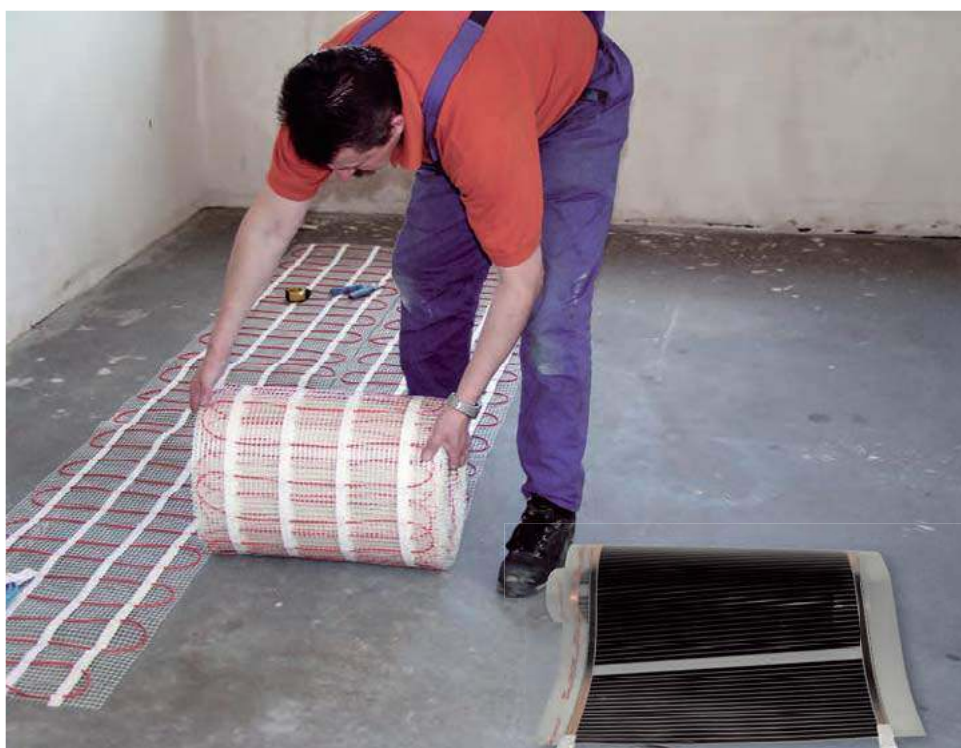
➡ Maty pod płytki oraz folie grzejne pod panele układa się bardzo łatwo. Ponadto na efekt ich włączenia nie musimy długo czekać. FENIX POLSKA
