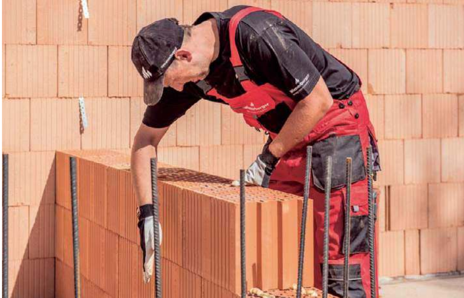
❶ Zaprawa, a właściwie klej w postaci pianki nie wprowadza wilgoci do muru. Cienka spoina wymaga jednak pustaków o szlifowanych krawędziach, a wykonawcy muszą być bardzo dokładni. WIENERBERGER
