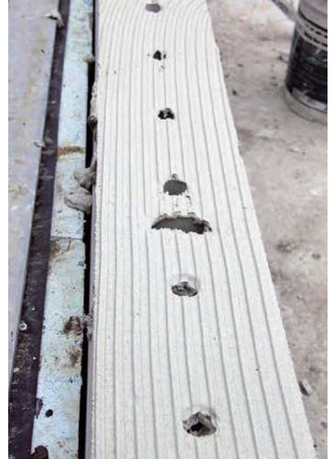
❗ Bloczki o dużej dokładności wymiarowej można murować na cienkowarstwowe zaprawy klejowe. J. WERNER
