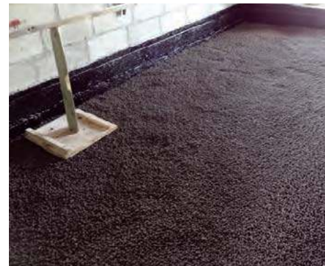
☛ Podłogi na gruncie można ocieplić styropianem typu dach/podłoga, albo materiałem zasypowym, np. keramzytem, który układa się jednak dużo grubiej.
