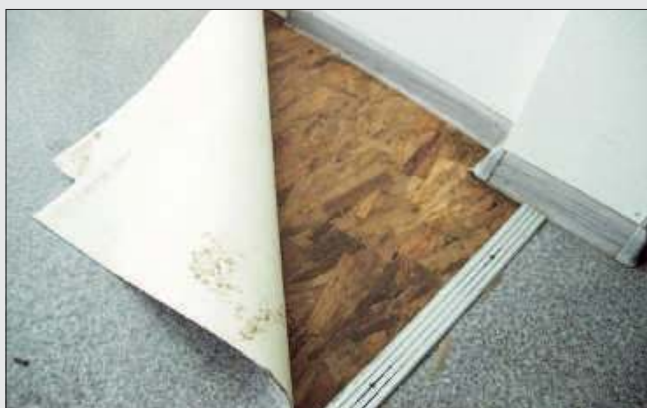
Wszelobocna wilgoć, przemoknięte podłogi, odchodzące linoleum, skroplona na ścianach woda – taki obraz przedstawiają obecnie kontenery nad Odrą w Raciborzu.
