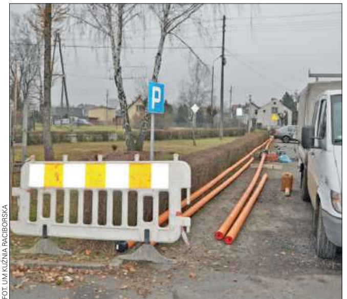
Wiele samorządów realizuje obecnie inwestycje, których celem jest gazyfikacja gmin. Na zdjęciu budowa takiej instalacji w Kuźni Raciborskiej.
