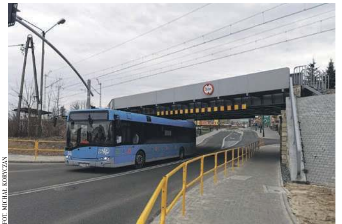
Po otwarciu zmodernizowanego wiaduktu na Krakowskiej w Chrzanowie niektóre autobusy jeżdżą tam na skróty, nie objeżdżając już miasta ul. Oświęcimską i Sienną
