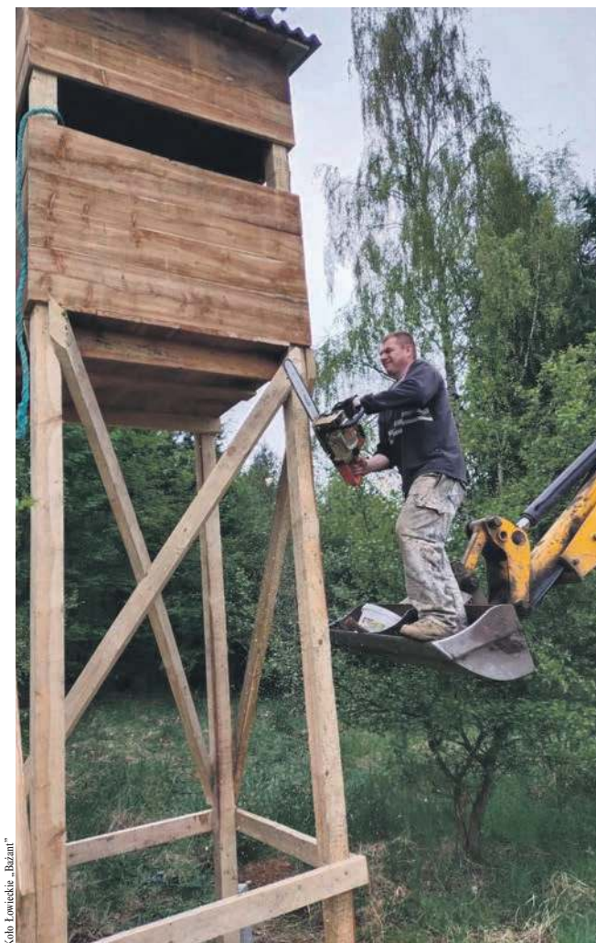
Prace gospodarcze. Budowa ambony
