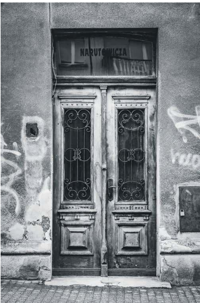
Brama wejściowa do kamienicy od strony ul. Narutowicza
