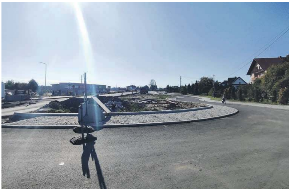
Budowa ronda w Alwerni
