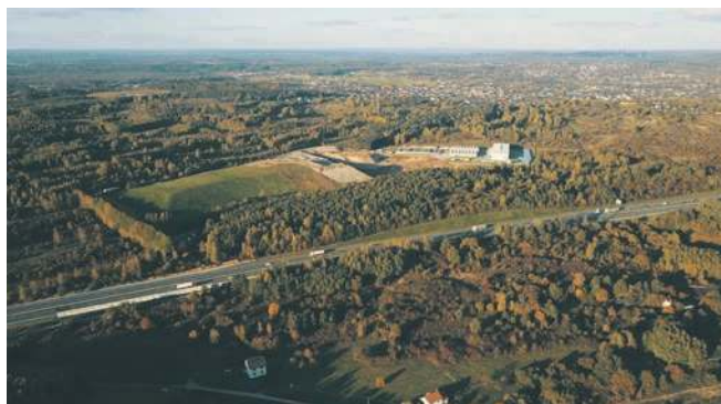
Składowisko odpadów w Balinie
