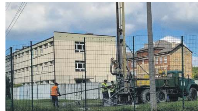
Prace przy SP nr 5 w Sierszy
