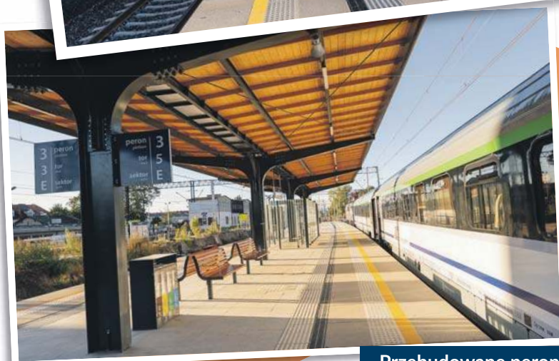
Przebudowane perony na stacji Słupsk
